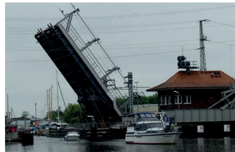
Das Queren der Eisenbahnbrücke stellt eine wichtige Besonderheit auf der Peene dar, durch die Stromleitung der Bahnlinie ist eine höhemäßige Begrenzung (ca. 8m) durch Boote und Schiffe zu berücksichtigen.
